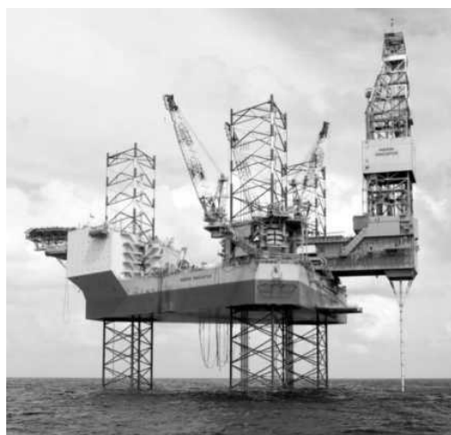
Hình 3. Giàn tự nâng 200m nước
