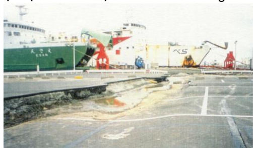
Hình 1. Các vết đứt gãy rộng 0,3m, sâu 0,5m - Cảng Hakodate
