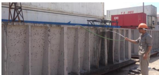
Hình 1. Khối bê tông cốt sợi thành mỏng đúc sẵn
