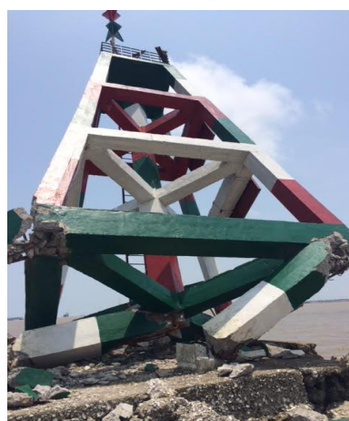
Hình 2. Đèn báo hiệu quả Xoài - Hải phòng mất khả năng chịu lực do cốt thép chịu lực bị phá hoại
